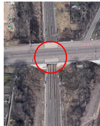
Brücke an der Arno-Nitzsche-Straße
