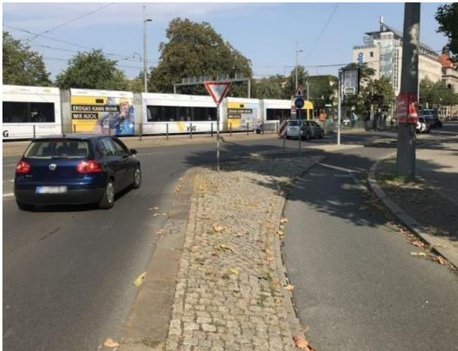
*Am Neuen Rathaus ist der Radfahrstreifen bereits mit einer gepflasterten Erhebung sicher vom Kfz-Verkehr getrennt.*
