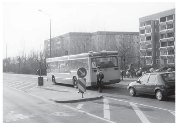
Abbildung 7 Die Mittelinsel an dieser Kaphaltestelle verhindert das gefährliche Überholen des Busses während des Fahrgastwechsels.
