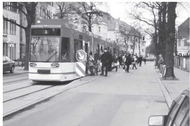
Abbildung 6 Zeitinseln ermöglichen das Ein- und Aussteigen auf der gesamten Haltestellenlänge. Die Fahrbahnanhebung ermöglicht den niveaufreien Zugang zu Niederflurfahrzeugen.
