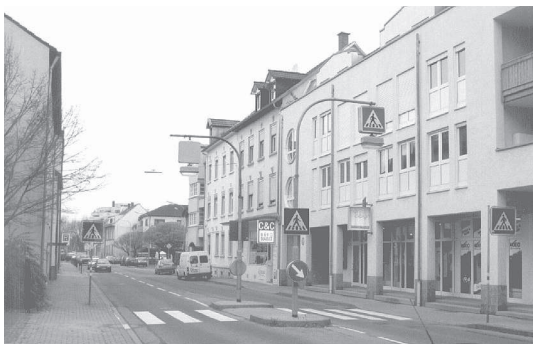
Abbildung 4 Mittelinseln oder Fahrbahnteiler halbieren die zu querende Strecke
